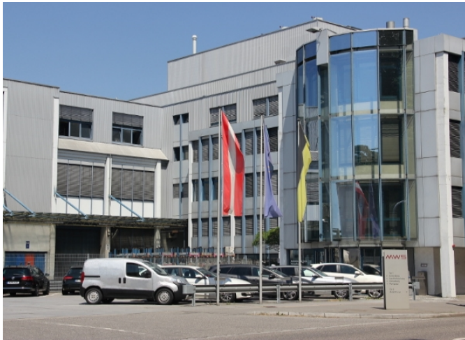
MWS Werk Friedrichshafen
